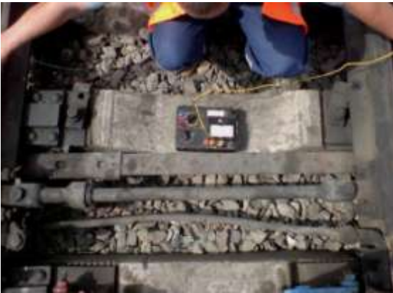
измерение между рамными рельсами
