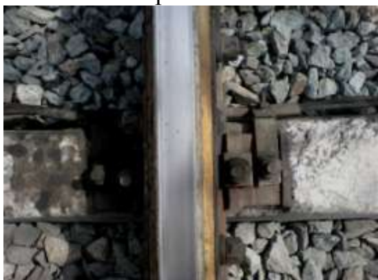
Целостность изоляции и расшивка
