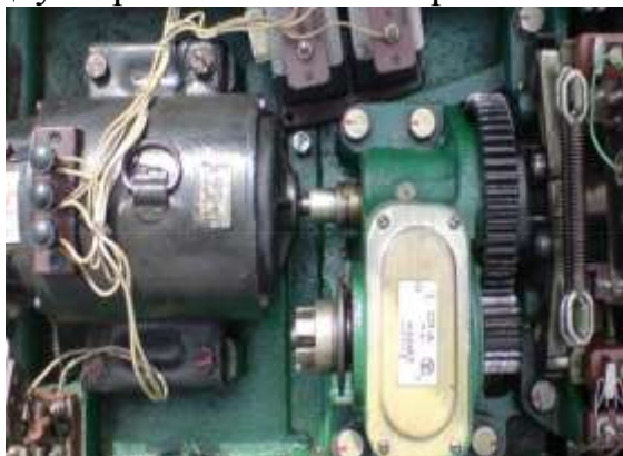
Визуальный осмотр редуктора
