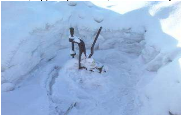
неочищенные стрелочные переводы
