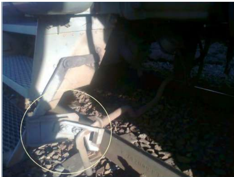
обрыв крепления кронштейнов расцепного привода
