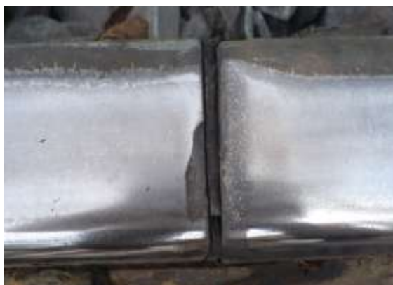
Целостность торцевой изоляции. Толщина не менее 5-8 мм
