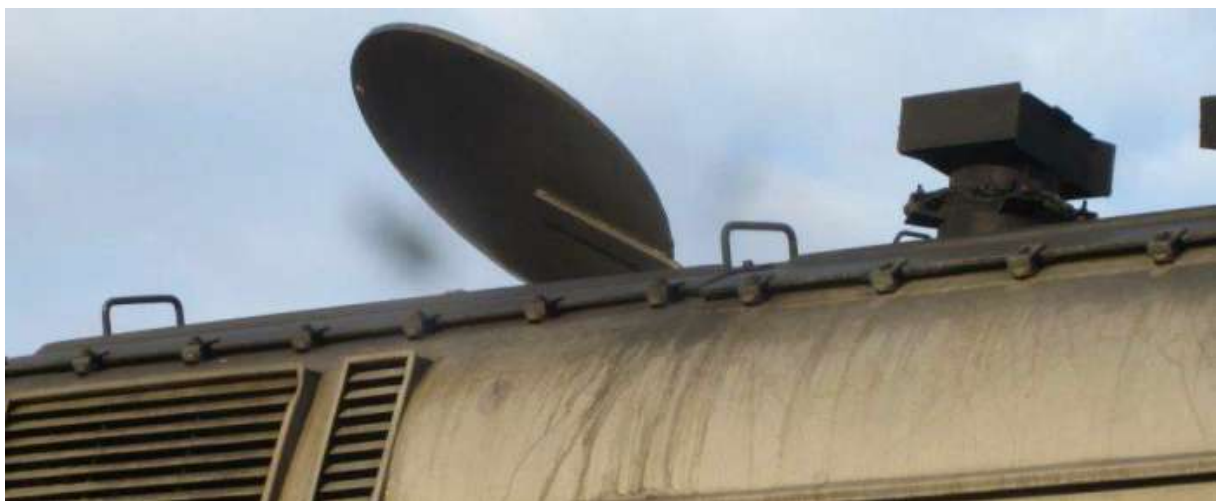
Открытые крышки (вентиляционных люков)
