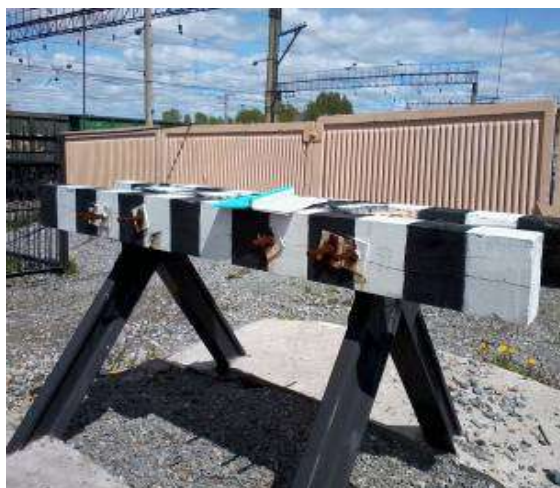
отсутствие сигнальных знаков на тупиковых призмах
