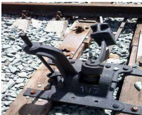
эксплуатация стрелочных переводов без сигнальных указателей и балансиров
