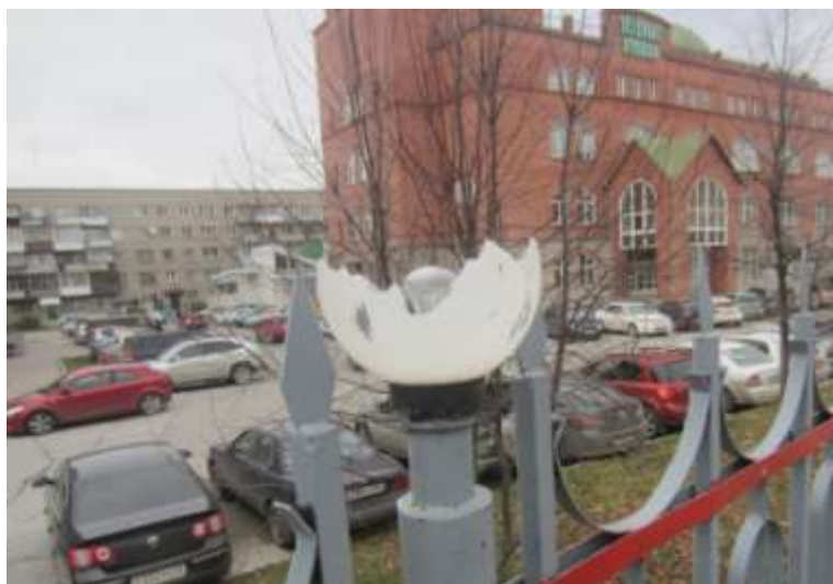
Отсутствие освещения, нарушение целостности конструкции средств освещения на посадочных платформах
