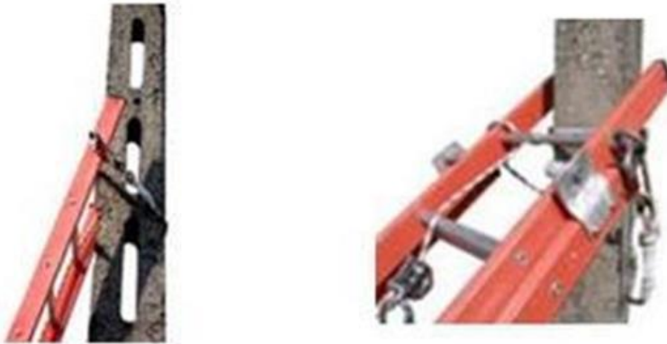
Рис.1. Варианты закрепления лестницы к опоре
